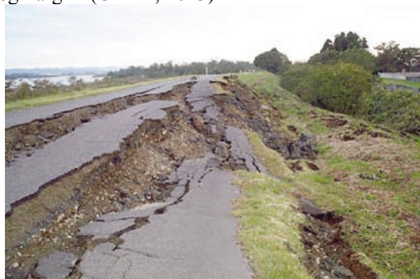
Figura 1. Collasso di un argine del fiume Shinano in Giappone a seguito del terremoto Niigata-ken Chuetsu-oki M6.6 del 2007 (da SWO, 2008).
