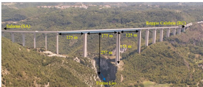
Figura 1 Vista aerea del viadotto Italia e della forra del fiume Lao
